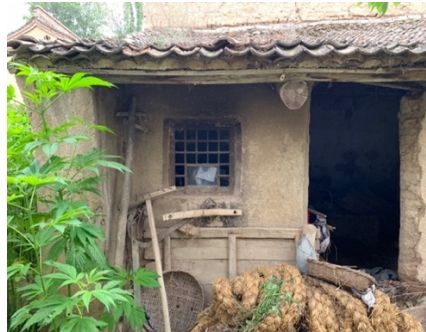
(d) Backyard utility room
